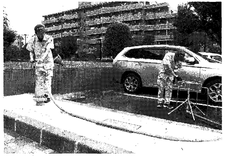
平成29年度までに市立小学校107校に設置予定小学校に消火栓を改良した応急給水栓を設置
