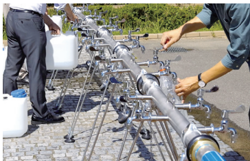
応急給水栓 使用中
