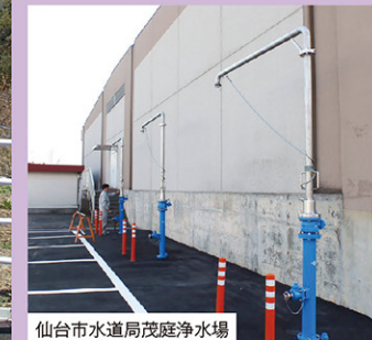
仙台市水道局茂庭浄水場
