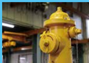
三方口消火栓
